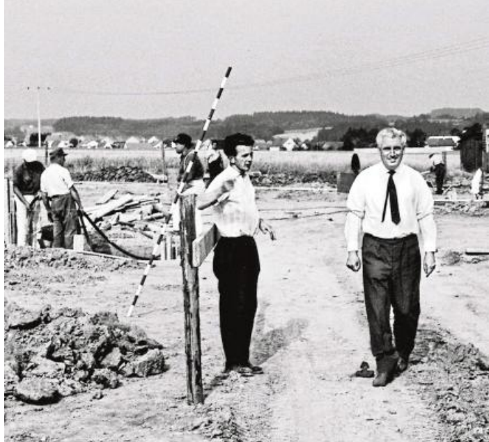
Fritz Dräxlmaier senior auf der Baustelle in Vilsbiburg.
