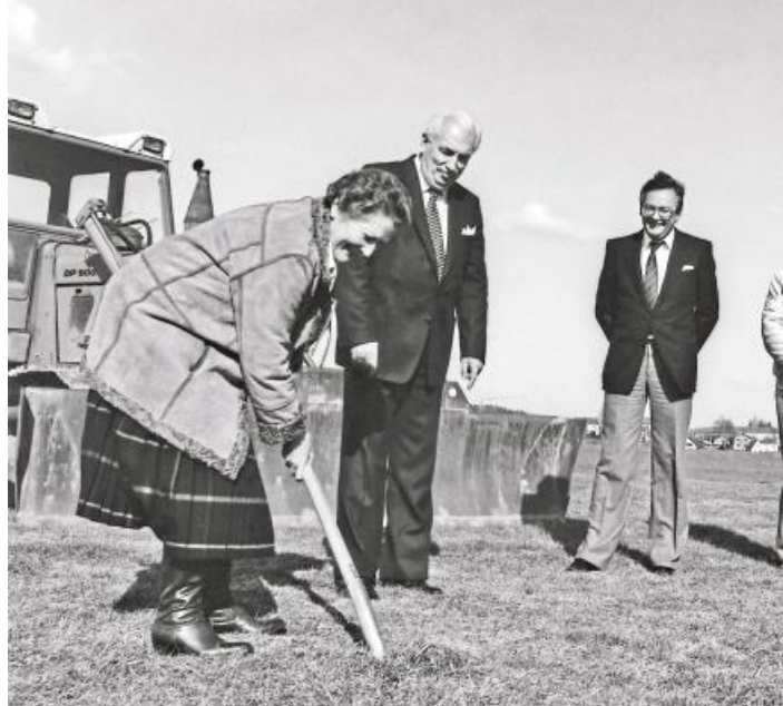
Lisa und Fritz Dräxlmaier sen. beim Spatenstich am heutigen Firmengelände in Vilsbiburg.
